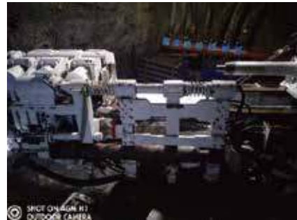
图 9 双管定向钻机现场试验
